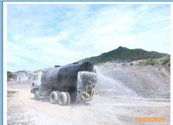
รูปที่ 3-8 การฉีดพรมน้ำ เพื่อลดการฟุ้งกระจายของ ฝุ่นละอองภายในพื้นที่โครงการ
