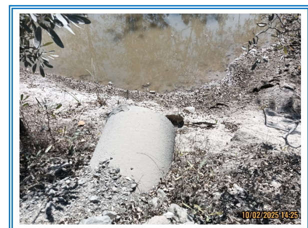
รูปที่ 3-21 ท่อระบายน้ำลงสู่บ่อดักตะกอน
